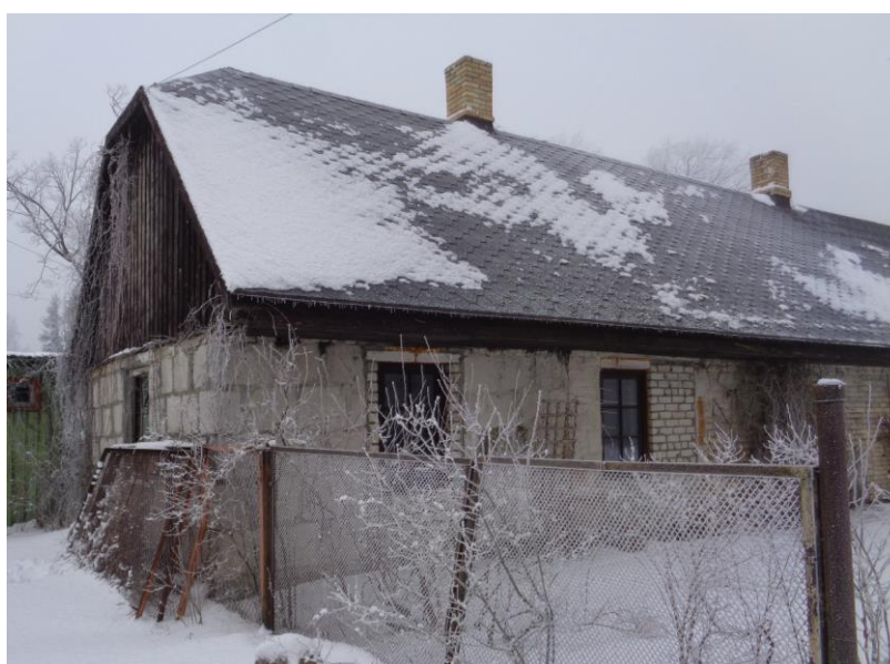
3. Brekšu iela 6, Jūrmala, domājamās daļas "1" apbūve
